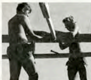
Thomas Sjöström och Evan Pettersson gör takkonstruktionen.
