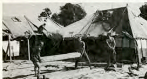
Tunga slipers av ädelträ baxas på plats för att bli gövreglar till Göta Källare.
