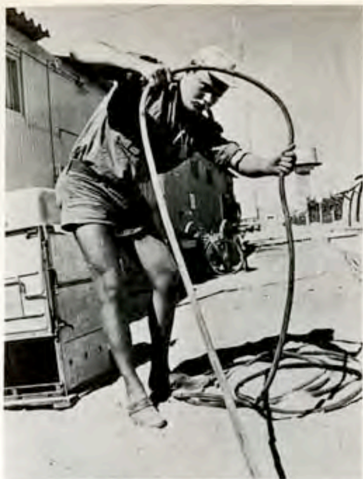
Elektriker Sture Palo såg till att vi fick ljus i våra hus och ström i våra kontakter.
