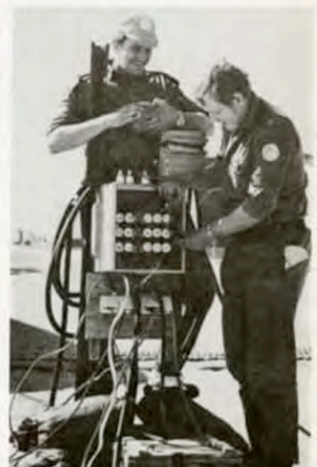
Ett under att det här elskäpet fungerar. Trots de provisoriska kopplingarna blir det ström på campen ändå. Paul Lindberg och Johnny Martinsson reparerar.
