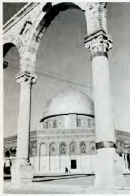
□ Den berömda Klippmoskén, byggd av kalifen Omar på 690-talet e. Kr.
