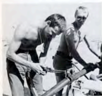
□ Jan-Ole Karlsson, Mjölby, och Conny Wahlberg, Strängnäs, kapar till ett rör som ska användas till att förstärka väggen i observationsvärnet.
