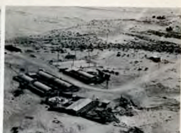
□ Norrtälje. Varför kallas egentligen området ovanför backen i Baluza så? Ja, något ska det ju betyda och eftersom det ligger lite norr om den stora bebyggelsen så... Där fanns förutom en hel del bostäder också NCO- och Private-mässarna, några förråd och strax intill Fastas radion med sin husvagn och - under den stora sandkullen - Radios Mallish-studion i vad som en gång var ett israeliskt skyddsrum.
